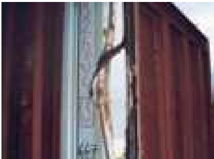
9 Loose door rubber gasket.
